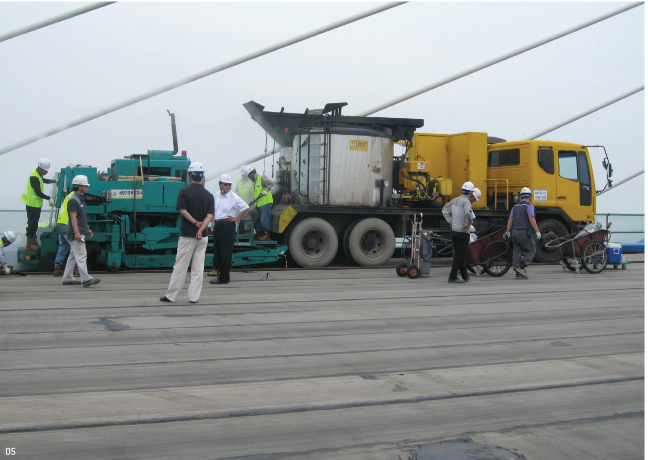
01 중앙분리대 시공 02 난간방호벽 시공 03 LMC포장 표면 레이턴스 제거 04 강상판 구스포장 05 파니셔와 구 스포장재 운반용 쿠커
