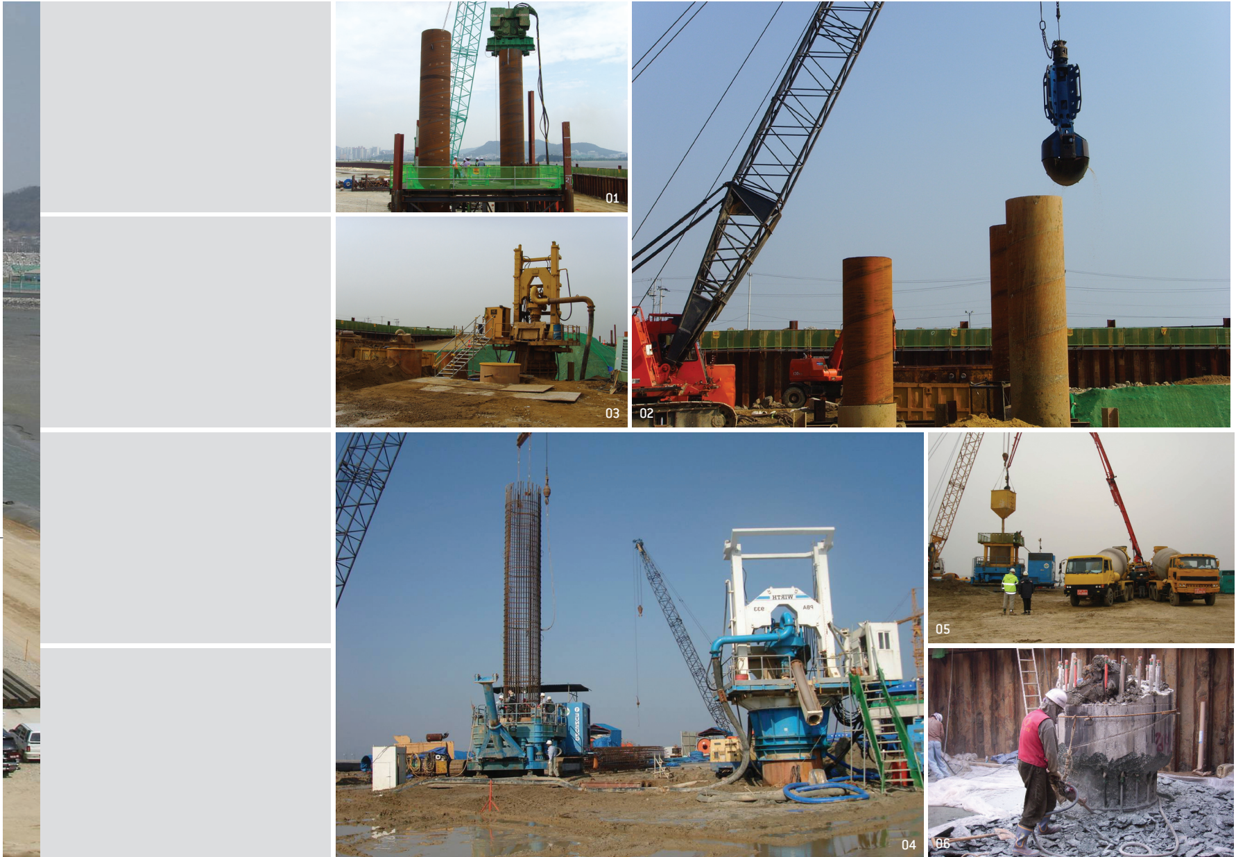
01 케이싱(희생강관)타입 02 햄머그라브를 이용한 케이싱 내부 굴착 03 RCD(reverse Circulation Drilling Method) 이용 암반굴착 04 철근망 근입 05 트래미관을 이용한 콘크리트 타설 06 브레이커를 이용한 말뚝 두부정리
