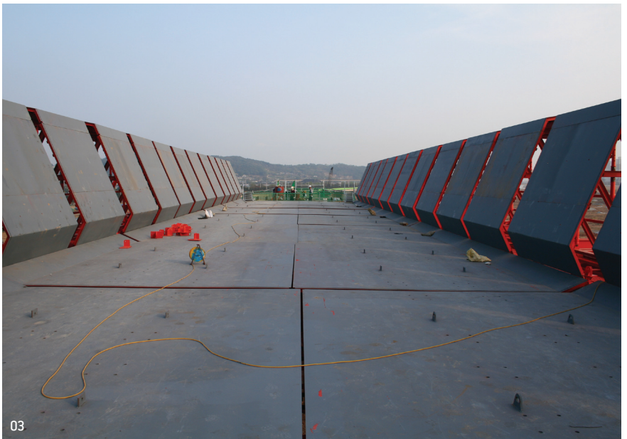
01 피어브라켓(Pier Bracket) 설치 02 MSS폼 설치 03 박스시공을 위한 거푸집 설치 04 스트럿 공장 제작 05 스트럿 설치 06 거푸집 정렬 및 마감
